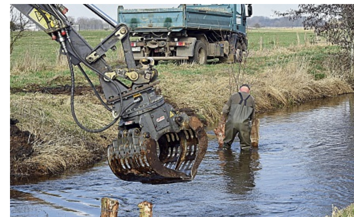
Mit Handarbeit und schwerem Gerät gehen die Mitarbeiter der Firma Josef Haschke vor.
